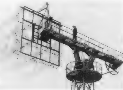
Bild 3. Die Abmessungen der Anlage läßt dieses während des Baues aufgenommene Bild erkennen. Die Sendeantenne ist fertig montiert. Rechts sieht man den Drehkranz für die Polarisationsänderung der Empfangsantenne. In der Mitte befinden sich die Schwenkgelenke und die Drehvorrichtung für die Gesamtantenne
